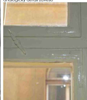
analogický detail zavírání s obrtlíkem
